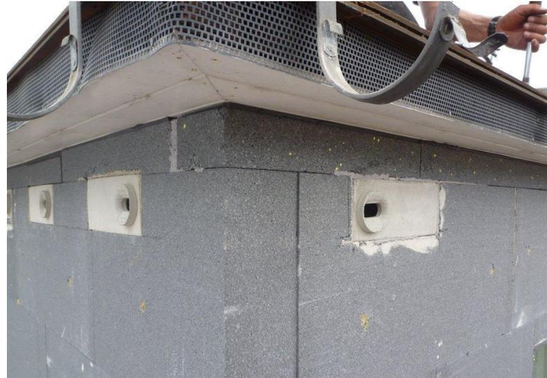
Dieser Schwegler-Einbaustein WDV 1A hat die Außenmaße: B 34x H 13,5x T 15 cm. Hinter dem Einbaukasten liegt noch eine dünne Styropor-Platte. Der Kasten wird mit Bauschaum eingesetzt und später überputzt: So ist nur noch der Einflugring zu sehen. Da Mauersegler saubere Mitbewohner sind, gibt es keine Verschmutzung der Fassade.
