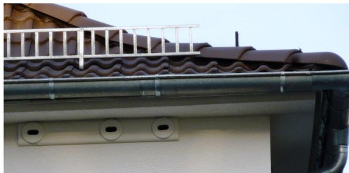
Nach dem Auftragen des Putzes schauen die Kästen nur ca. 2 cm heraus. Das ist von unten kaum wahrnehmbar und für das Gebäude und die Mauersegler eine elegante und dauerhafte Lösung. Die Kästen müssen nicht gereinigt werden. Mauersegler tragen nur wenig Nistmaterial ein. So sind die Plätze für Jahrzehnte nutzbar.
